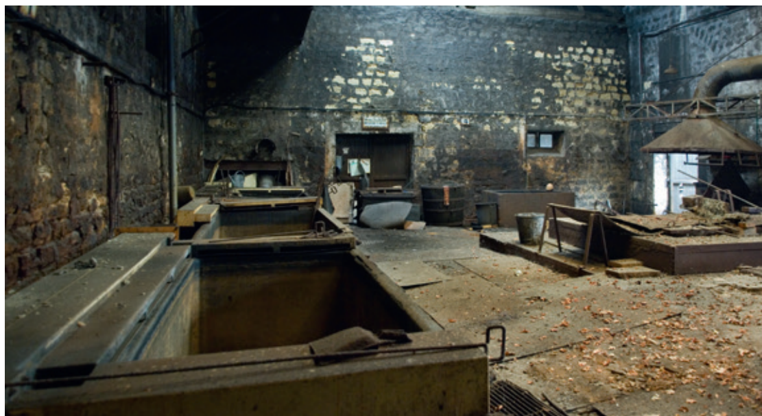
Matériel (bacs à acides) ayant contenu des produits polluants dans un ancien atelier de métallurgie.
