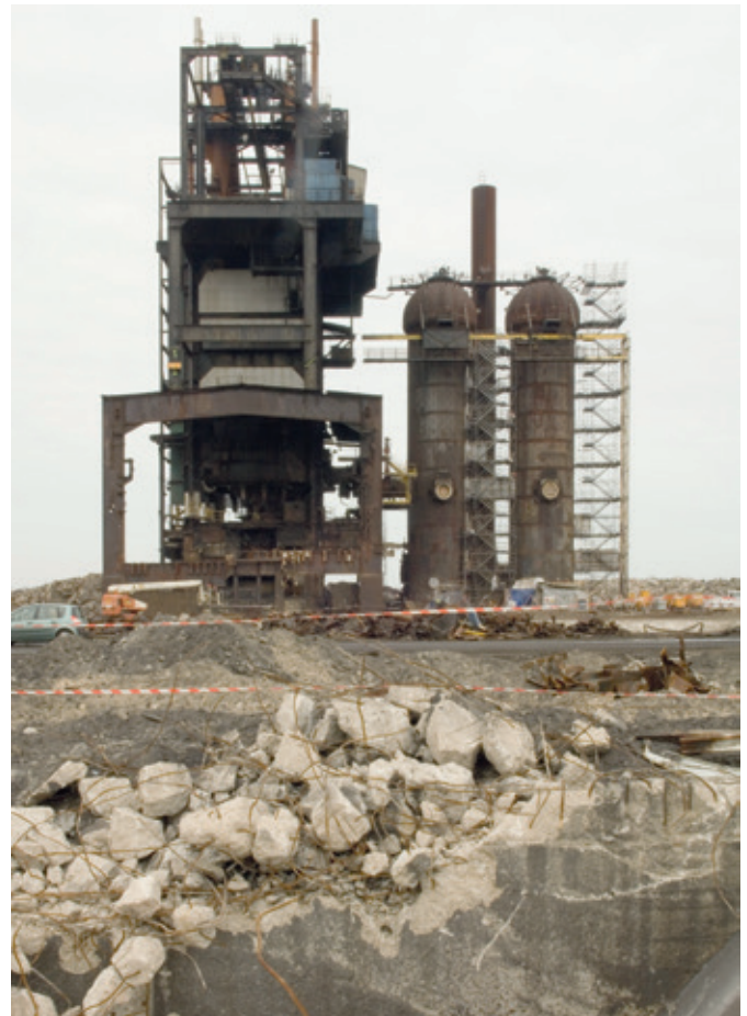
Démantèlement d'un ancien site industriel (Nord - Pas-de-Calais).
