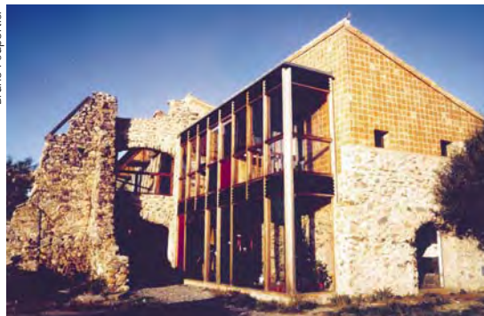
Véranda accolée à une maison ancienne, maintenue fraîche par une toiture opaque, une ventilation adaptée et une forte inertie thermique.
