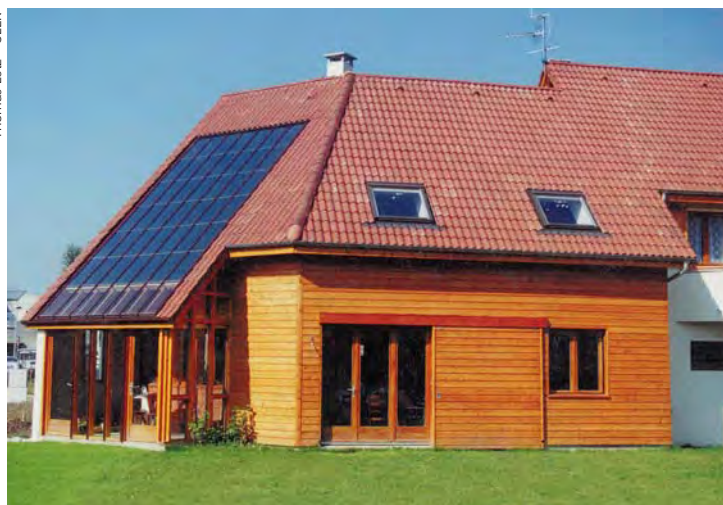
Système de chauffage par plancher solaire dans une maison construite en 1994 : le capteur chauffe l'eau qui circule dans un plancher chauffant.
